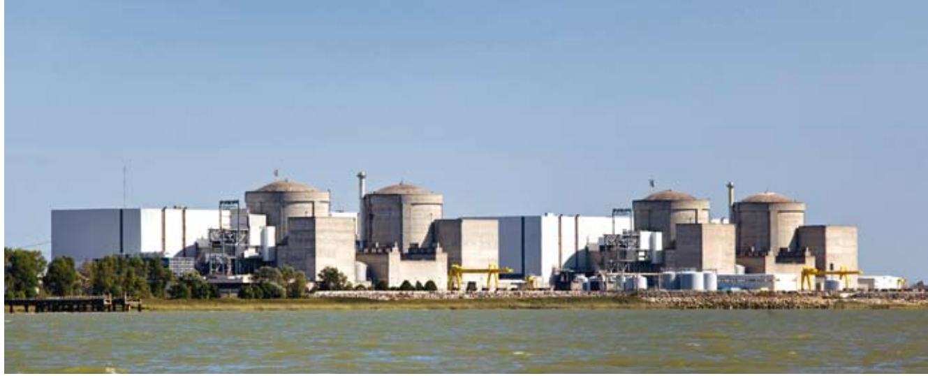
La centrale du Blayais, sur la Gironde, en service depuis 1981. Elle fut inondée lors de la tempête du 27 décembre 1999.
